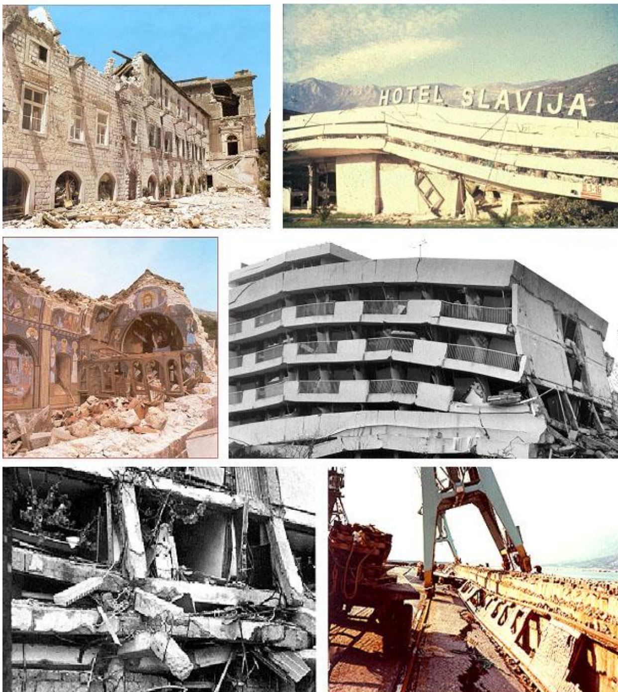
Slika 12. Ilustracija nivoa i tipova destrukcije na objektima u zemljotresu 15. aprila 1979.: detalj iz starog grada Budva, hotel "Slavija" u Budvi, Manastir "Gradište" u Buljarici, Hotel "Agava" u Baru, zatim detalj oštećenja tog hotela i gat broj 2 u luci Bar.
